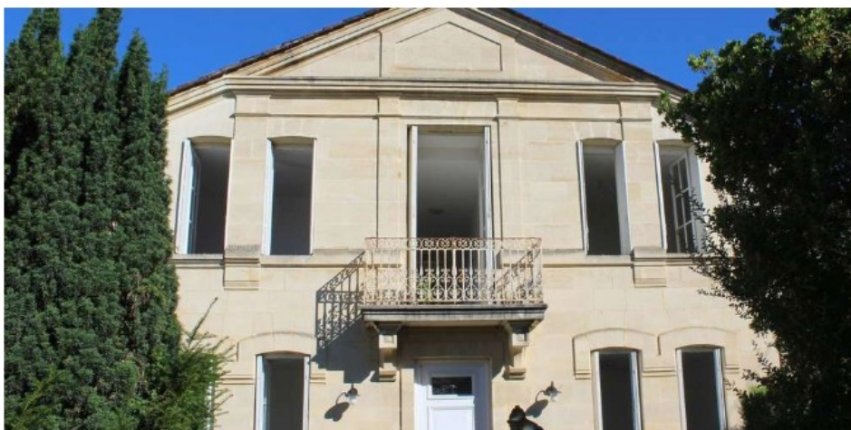
▲ Le bâtiment abritera 8 logements. ©ARCHIVES P. C.
